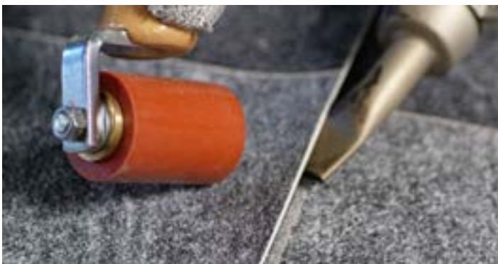
Soldadura mediante solape
