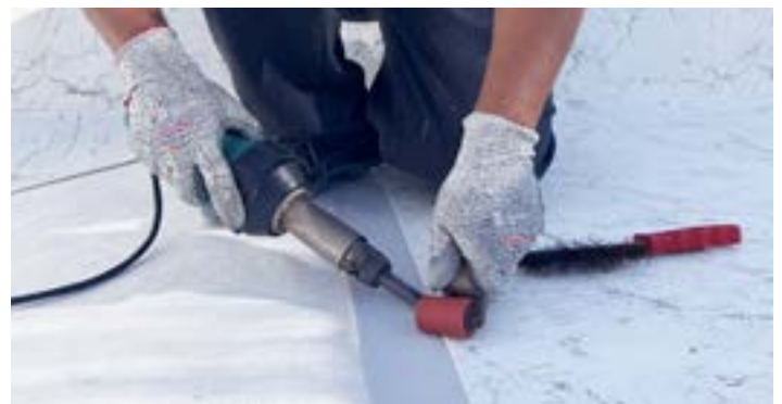
Soldadura a testa
