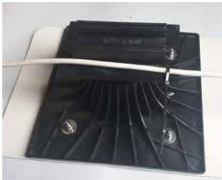
Los cables de prolongación para la conexión al ondulador deben fijarse con collarines de apriete en el reborde del marco del panel para reducir los efectos del bucle inducido. Las aletas del soporte pueden perforarse con un taladro cónico para pasar un collarín de apriete tipo Colson, que permitirá apretar el cable que se apoyará sobre la aleta. Esto evita el contacto con la membrana de Impermeabilización y el posible estancamiento del agua alrededor de los cables y conectores.
