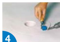
4 Soldar por puntos, pre-soldar y soldar el **DESAGÜE PLUVIALES PVC** en la superficie horizontal.
