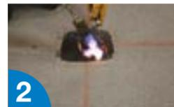
2 Impregnar con el soplete la pizarrilla de la lámina bituminosa en el área donde se instalará el soporte.
