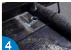
4 Aplicar el sistema de impermeabilización bituminoso de la cubierta sobre el **DRAINI**.
