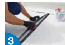
3 Limpiar y sanear la superficie a soldar, la cara superior del perfil, con disolvente **FLAGON CLEANER PVC**.
