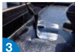
3 Adherir **DRAINI** al soporte y con la ayuda de un paletín ir desdoblando y colocando la banda. Se aplica fuego hasta obtener una rebaba para sellar con el paletín.
