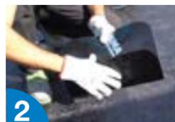
2 Cortar el tubo de **DRAINI** a la medida de fondo de desagüe insertándola en el agujero. Se doblan las alas de la banda de la cazoleta sacándolas del cartón.
