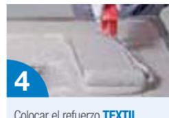
4 Colocar el refuerzo **TEXTIL** precortado para doble refuerzo, aplicando una cantidad suficiente de resina también en alrededor del refuerzo, acotando la zona en unos 50x50 cm.
