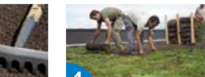
3 Colocar perfiles en los límites o limitar la zona vegetal. Extender **SOPRAFLORE EXTENSIVO** en toda la cubierta a 7 a 10 cm.
