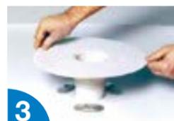
3 Limpiar con un trapo impregnado de **FLAGON CLEANER**, las superficies a soldar. Inserte el elemento prefabricado **DESAGÜE PARA PLUVIALES PVC**.
