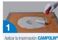
1 Aplicar la imprimación (**CAMPOLIN® FIBER** diluido 20% con agua) con un rodillo o un pincel ~ 0,5 kg/m<sup>2</sup> según rugosidad. Deje que cure 2-4 horas y cubrir el área de actuación con **CAMPOLIN® FIBER** con un pincel o rodillo. (~ 0,7-1,5 kg/m<sup>2</sup>).
