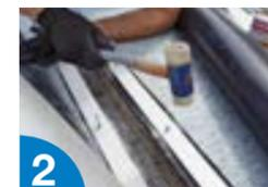
2 Fijar el **PERFIL DE FIJACIÓN PVC** con tacos de expansión sobre el suelo cada 25 cm, dejando la cara de PVC vista.
