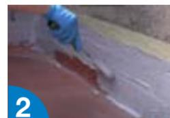
2 Aplicar mezclando con 20% de agua, como imprimación. **CAMPOLIN® FIBER** (0,6 - 0,75 kg/m<sup>2</sup>).
