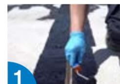
1 Imprimir la superficie con **EMUFAL PRIMER** o **SOPRADERE** a razón de ≈150-300 gr/m<sup>2</sup> según rugosidad y material.
