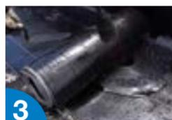
3 Aplicar el sistema de impermeabilización bituminoso de la cubierta.
