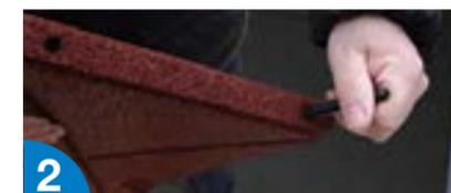
2 Preparación de **SOPRACOVER DALLE**: instalación de las barras de conexión.
