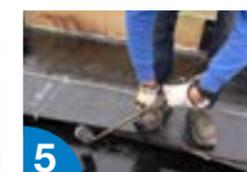
5 Cortar a medida y adherir a fuego completamente la banda de terminación de ≥30 cm **MORTERPLAS BAND** centrada en la junta.
