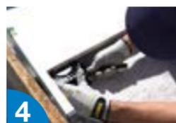
4 Ajustar con la llave incluida en la bolsa los soportes hasta quedar nivelados en ambos sentidos.
