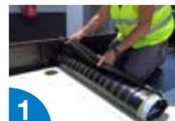
1 Aplicar 1ª capa de impermeabilización bituminosa sobre el soporte o aislamiento.
