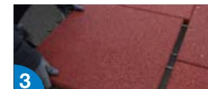
3 Colocar **SOPRACOVER DALLE** a rompejuntas directamente sobre la impermeabilización.
