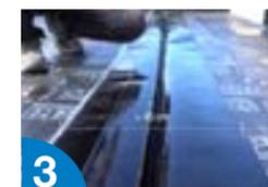
3 Cortar a medida y adherir a fuego completamente la banda de dilatación de ≥45 cm **MORTERPLAS SBS FP 4 KG** centrada en la junta y creando un fuelle.
