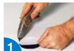
1 Cortar la lámina anteriormente instalada en la superficie horizontal en correspondencia con el agujero del desagüe.
