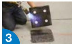
3 Calentar el film antiadherente de la base del soporte con el soplete.
