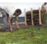
4 Extender manualmente los rollos de **SOPRANATURE® SEDUM MIX MAT** sobre las tierras sin solapar.
