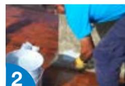
2 Aplicar la primera capa de **TEXPUR** (1-1,5 kg/m<sup>2</sup>) tras haber imprimado previamente según soporte.
