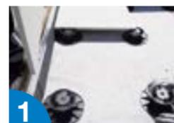
1 Replantar según el tamaño de la baldosa. Colocar los primeros **SOPORTES DE ALTA RESISTENCIA** en los bordes cortando las alas de la cabeza.
