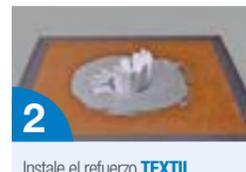
2 Instalar el refuerzo **TEXTIL** precortado (peine) sobre la resina húmeda **CAMPOLIN® FIBER**. Usar rodillo para eliminar arrugas y burbujas de aire. Saturar completamente todo el **TEXTIL**.
