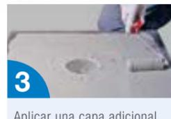
3 Aplicar una capa adicional de **CAMPOLIN® FIBER** sobre la superficie aún húmeda (~ 0,7-1,5 kg/m<sup>2</sup>) y dejar secar 12-24h.
