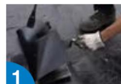
1 Imprimir la superficie con **EMUFAL PRIMER** o **SOPRADERE** a razón de 150-300 gr/m<sup>2</sup> según rugosidad y soldar refuerzo de 50x50 cm con lámina **MORTERPLAS SBS FP 4 KG**.
