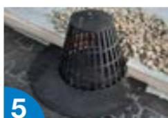
5 Colocar apoyado sobre la impermeabilización el **PARAGRAVILLAS SOMBRERO** y aplicar el resto de capas de la cubierta lastrada.
