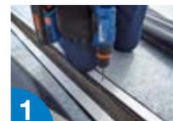
1 Replantear **PERFIL DE FIJACIÓN PVC** a cada lado de la junta, agujereando cada 25 cm para añadir el taco.
