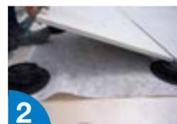
2 Colocar las **BASES AMORTIGUADORAS** y la baldosa **SOPRADALLE CERAM** sobre las cabezas de los soportes ajustándose a las alas.
