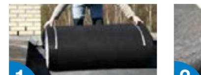
1 Posicionar y desenrollar el drenaje **DRENTEX IMPACT GARDEN** sobre el soporte.
