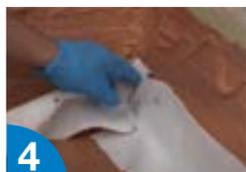
4 Adherir **TEXTIL** (armadura) sin burbujas ni pliegues, cuando la capa está aún húmeda.
