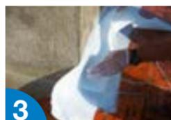
3 Adherir **TEXTIL** (armadura) sin burbujas ni pliegues, cuando la capa está aún húmeda.
