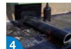
4 Aplicar el sistema de impermeabilización bituminosa de la cubierta y rellenar la junta con el cordón bituminoso **JOINFAL**.
