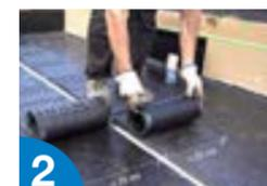
2 Adherir a fuego completamente la **MORTERPLAS BAND**, paralela a lado y lado de la junta como banda de adherencia.
