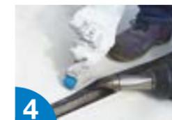
4 Soldar la lámina de la cubierta sobre el **PERFIL DE FIJACIÓN PVC** a cada lado, dejando la junta libre.
