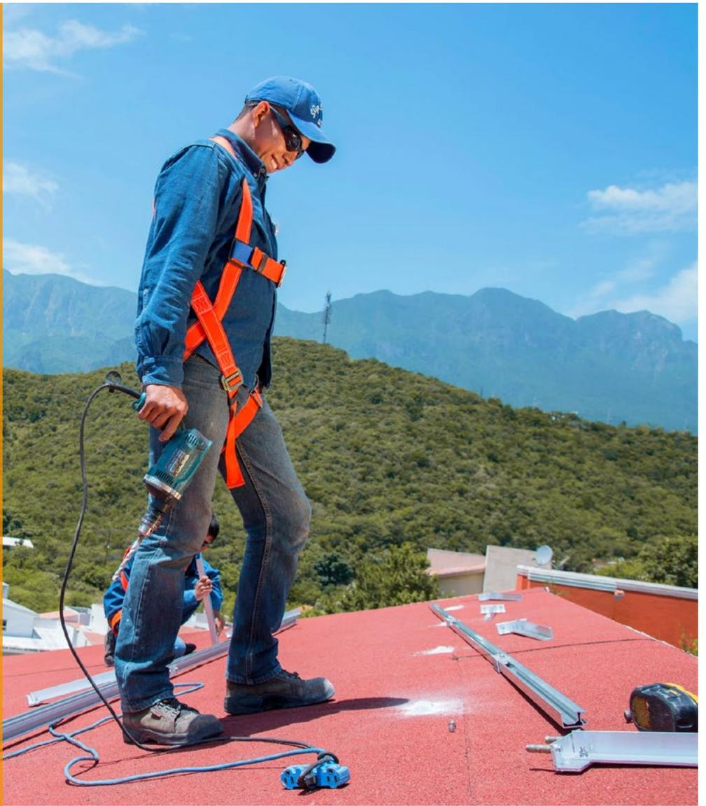
Los sistemas **SOPRASOLAR®** **FIX EVO** y **EVO TILT** entrarían dentro de este tipo de soluciones soldadas. Presentan un sistema sencillo y rápido de puesta en obra, sin perforaciones, asegurando la total estanqueidad, sin riegos de goteras ni posibles daños de la capa de impermeabilización de la cubierta, ya sea bitumen, PVC o TPO.
