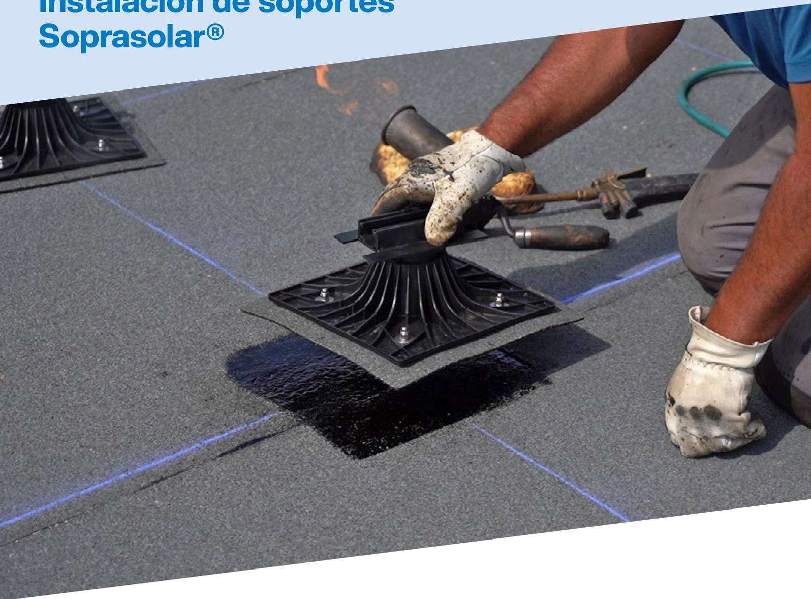
La instalación de un sistema **Soprasolar®** para un proyecto requiere de un **estudio previo** y la aprobación del departamento técnico de **SOPREMA**. Es imprescindible realizar un estudio de viabilidad de la instalación de los soportes en dicha cubierta, especialmente en obras de rehabilitación, puesto que hay factores que impiden la instalación de dichos soportes, como, por ejemplo, una lámina impermeabilizante existente de otra marca.
