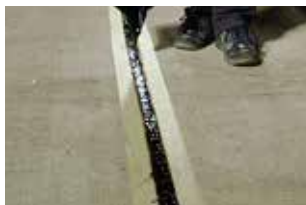
Relleno de juntas de aeropuerto
