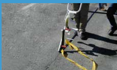
Relleno de fisuras con asfalto (Stratos R2 con herramienta de instalación)
