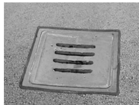
Instalación de juntas de un pozo de registro (Stratos R1)
