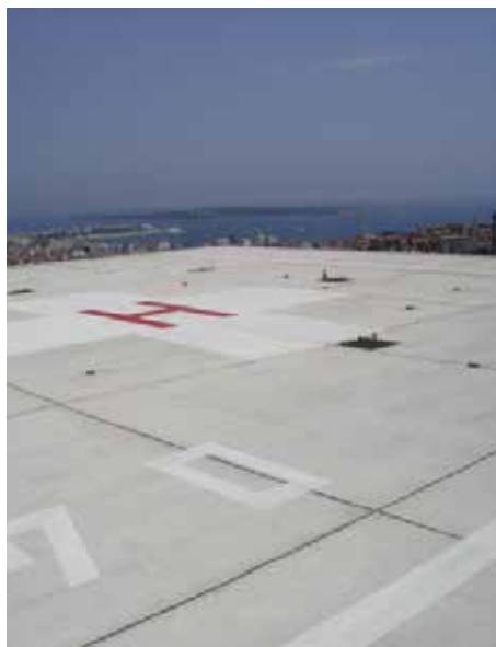
Juntas resistentes al queroseno en un helipuerto (Stratos R4)
