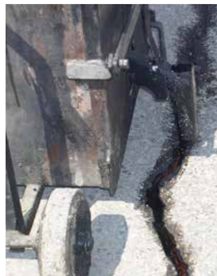
Relleno de fisuras con asfalto caliente (Transifal C40)
